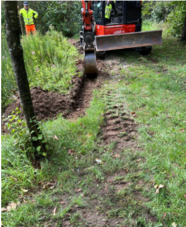
Abbildung 7: Der Graben für den Amphibienschutzzaun wird gezogen.
