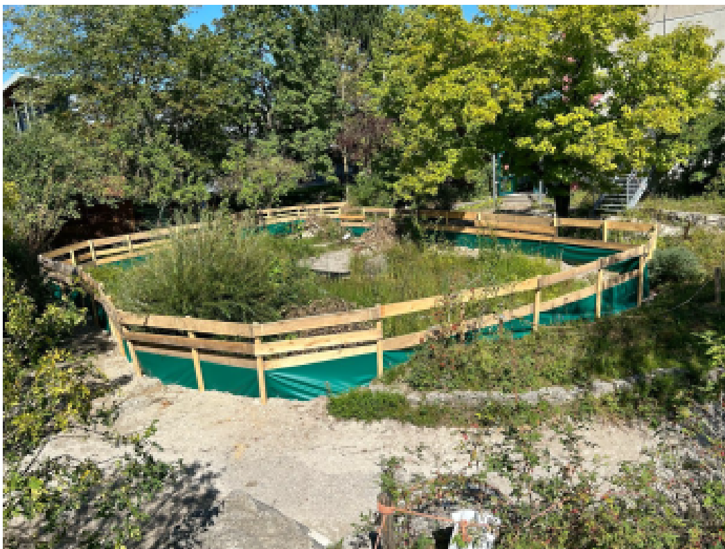
Abbildung 8: Der Amphibienzaun wird 10 cm im Erdreich versenkt, Übersicht.
