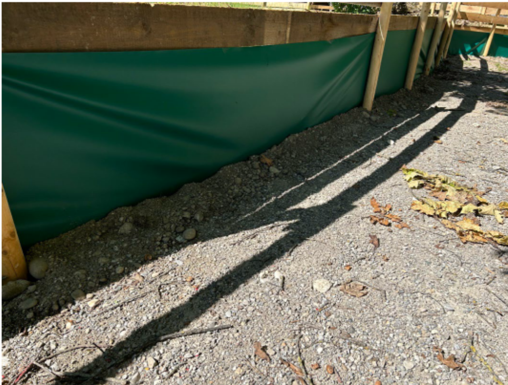
Abbildung 9: im Bereich der Eiche wird der Zaun zum Schutz der Wurzeln nicht eingegraben.
