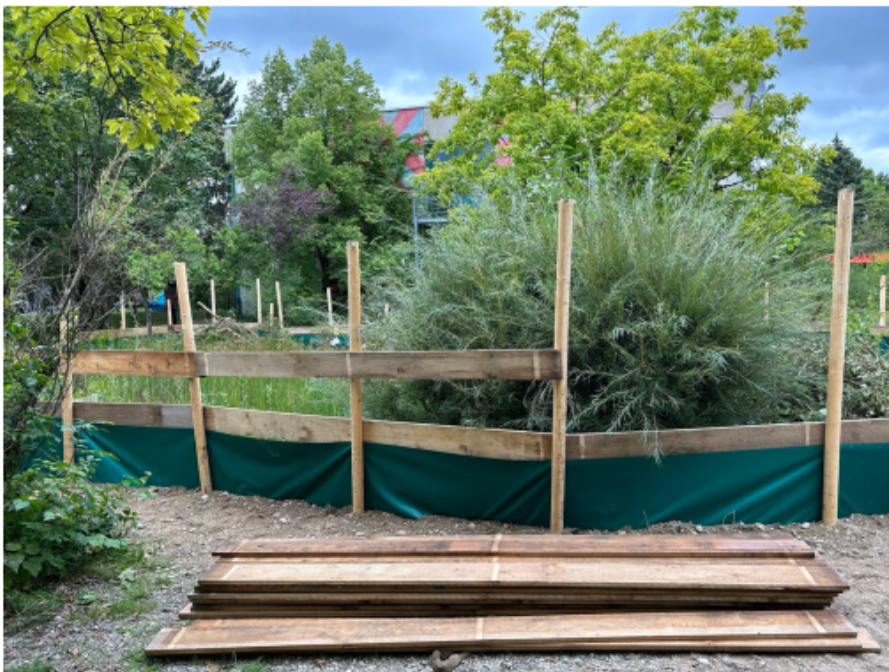
Abbildung 10: Kindersicherung mit 2 Brettern.
