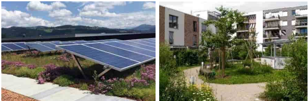
Abbildung 15: Extensive Dachbegrünung mit PV und intensiv begrünte Tiefgaragen (HL)
