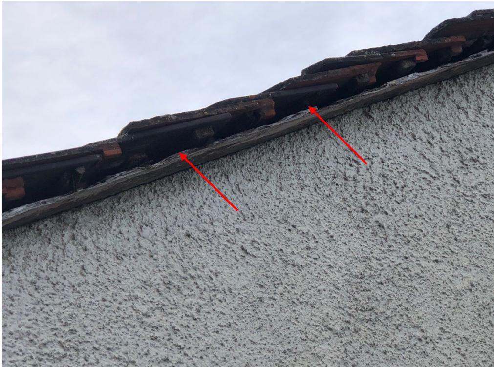
Abbildung 6: Einflugmöglichkeiten für Fledermäuse und Sperlinge in den Dachbereich des Gebäudes an der Nord-Ostfassade (rote Pfeile).
